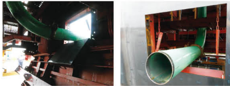
コンクリート配管を窓から出している様子
