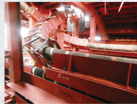
上部窓から耐圧ホースを出している様子
